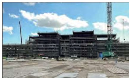
北側から建物本体(10/12撮影)
